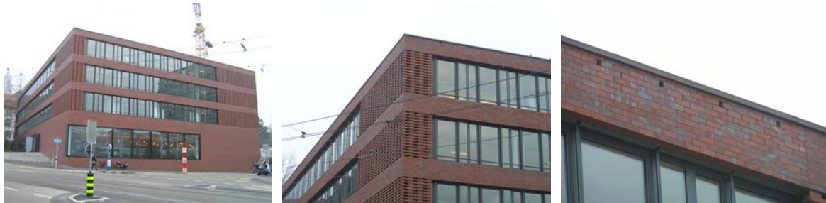
Fotos 30-32: Neuschaffen: Brutmöglichkeiten für Mauersegler im Flachdachabschluss eines neuen Gebäudes. (© Michael Stocker)
