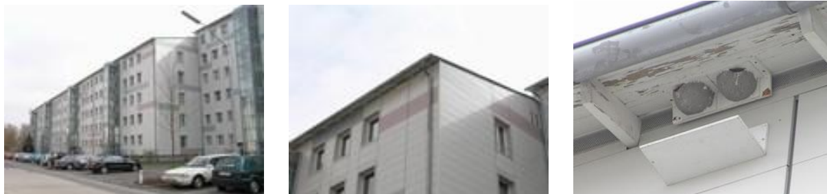
Fotos 27-29: Brutmöglichkeit wieder herstellen: Künstliche Nisthilfen auf der neuen wärmeisolierten Fassade eines Hauses, das vor der Renovierung von Mehlschwalben besiedelt war. (© Michael Stocker)
