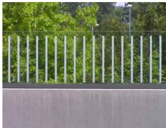
Fotos 33-34: Wirksame Glasmarkierungen. Links: Begrenzung eines Aussichtspunktes im Tiergarten Schönbrunn (leider ist das Muster nicht bis ganz an den oberen Glasrand gezogen), rechts: Lärmschutzwand entlang einer Strecke der Schweizerischen Bundesbahnen (© M. Stocker).
