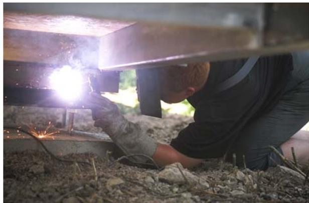
Abbildung 7: ....und auf dem genau horizontierten Drehkranz festgeschweißt.
